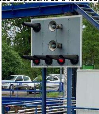
Figure 55 : Feux de navigations d'entrée de sas
