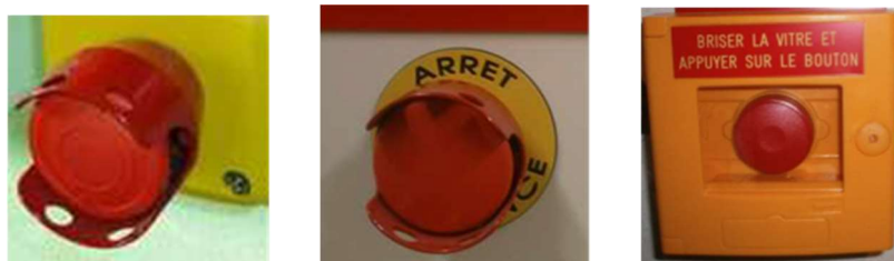
Figure 45 : Coupure d'urgence (de gauche à droite) : Type 1a – Type 1b – Type 2
