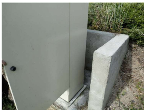
Figure 35 - Exemple de mise en œuvre du muret en parpaing protégeant l'armoire
