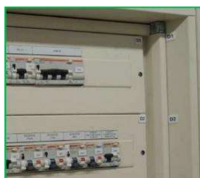
Figure 48 : Étiquetage des plastrons
