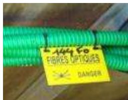
Exemple d'étiquette pour les gaines
