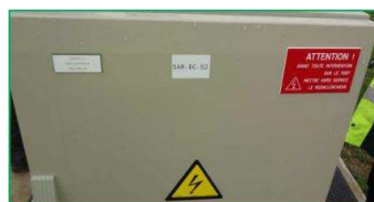
Figure 47 : Exemple d'étiquetage sur un coffret extérieur
